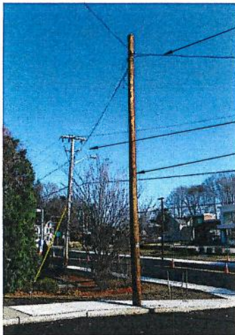
EXISTING CONDITIONS PHOTO DETAIL 2 A-1 SCALE: N.T.S.
