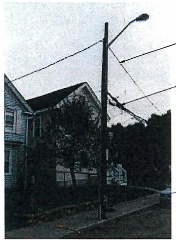
EXISTING CONDITIONS PHOTO DETAIL SCALE: N.T.S
