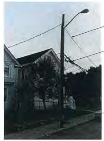
EXISTING CONDITIONS PHOTO DETAIL SCALE: N.T.S.
