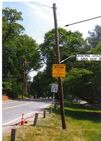
EXISTING CONDITIONS PHOTO DETAIL SCALE: N.T.S
