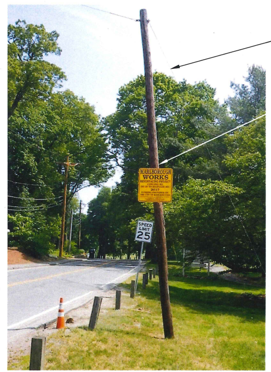
EXISTING CONDITIONS PHOTO DETAIL SCALE: N.T.S.
